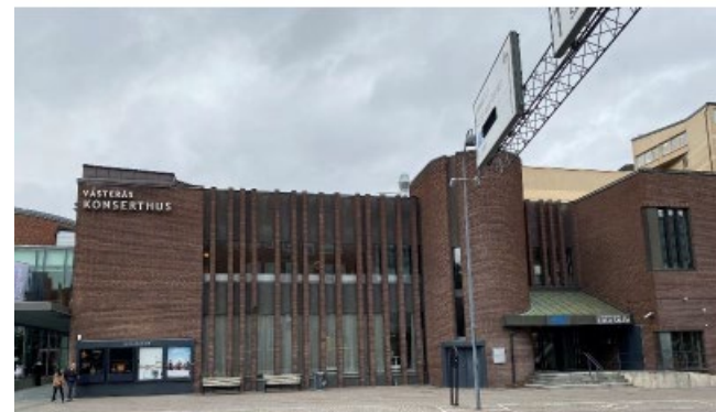
Foto: Västerås stad. Njord 8, fasader längs Kopparbergsvägen i dagsläget.
