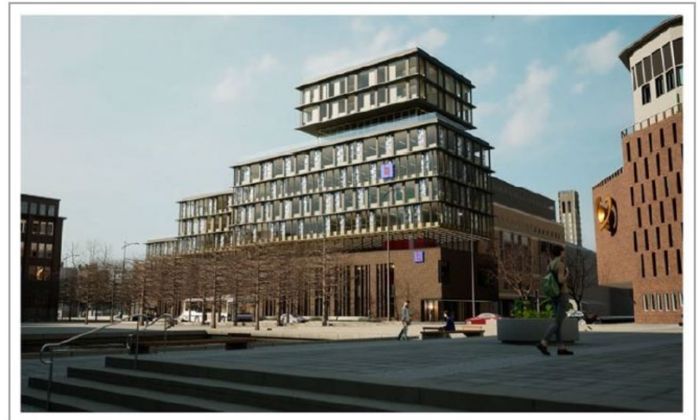
Konserthuset/Forumbyggnaden före och efter ombyggnation.
